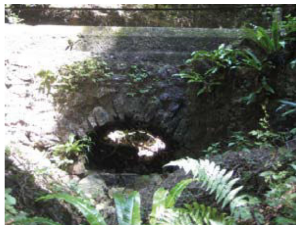
Terzo ponte canale con luce di due metri.
