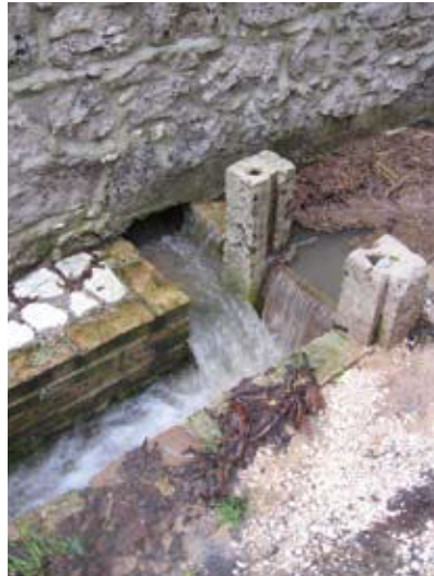
La chiusa ai piedi della Maritera, permetteva di accumulare acqua in una cisterna che si trova dietro il muretto.
