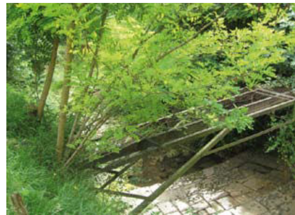
Residui in ferro di un ponte che permetteva di portare in una ghiacciaia, a destra del corso del Rujo, i latticini da conservare al fresco.
